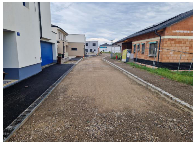
Kirchfeldsiedlung – Sonnengasse Der Straßenbau schreitet voran.
